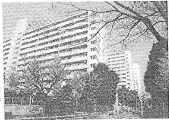
東京都板橋区の高島平団地
